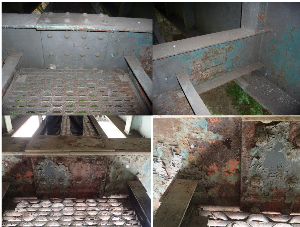
Obr. 9 Obvyklý stav příčníku v poli (nahore), K02 příčník 1 poškození důlkovou korozí (dole)
