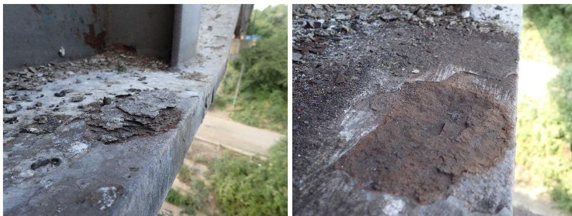
Obr. 7 Ložisko lok. koroze na spodní pásnici u P02
