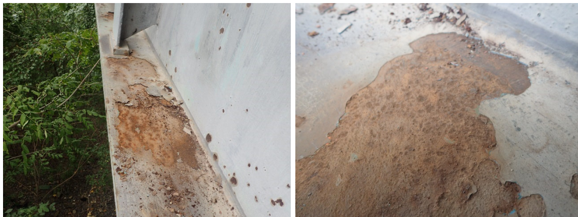
Obr. 19 Typické ložisko lokální důlkové koruze
