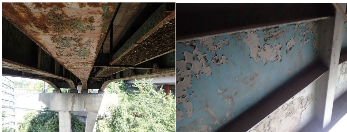
Obr. 3 Začínající koroze spod. Pásnice, loupající se nátěr PKO
