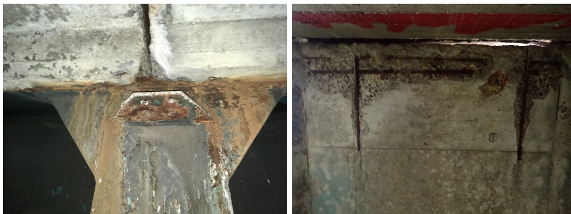
Obr. 11 Dil. spára nad P01-K01(vlevo), O02-K02 spára u opěry
