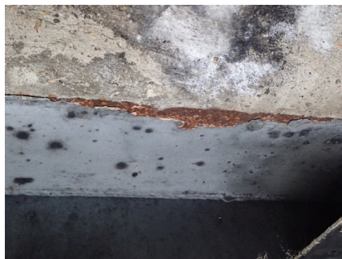
Obr. 4 Korozní oslabení na styku hrany horní pásnice hl. nosníku s betonem, důlky 1-2mm
