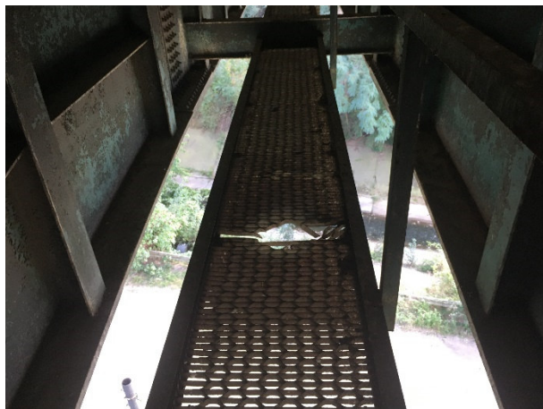
Obr. 14 Prokorodování podlahového roštu ser. lávky
