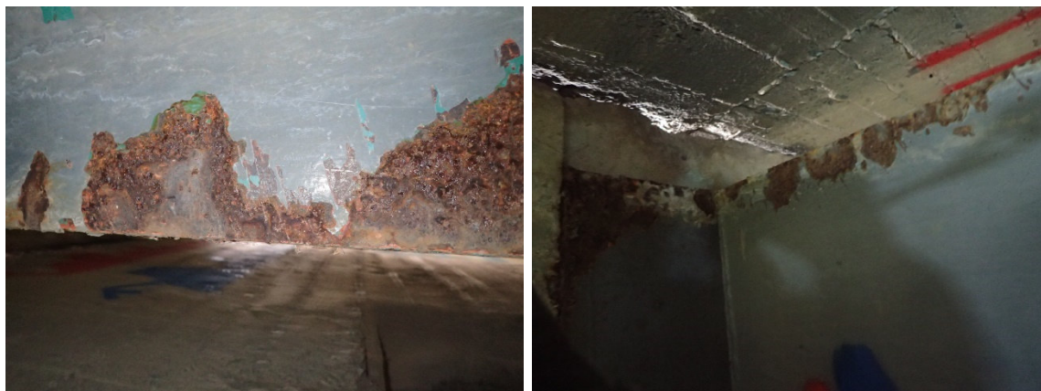
Obr. 8 Lokální koroze na konci hl. nosníku O02 od stékající vody
