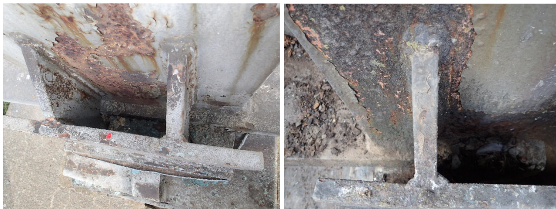
Obr. 20 K02 P01 Poškození korozí v zesílení výztuhy (pravý a levý nosník)
