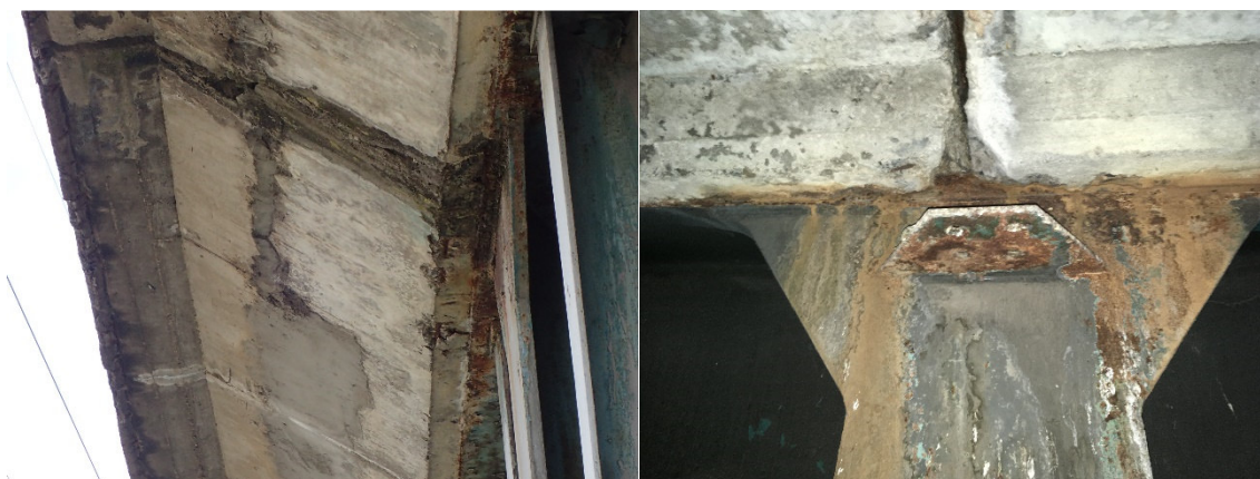
Obr. 21 K02 P01 Koroze od vody protékající dilatační spárou
