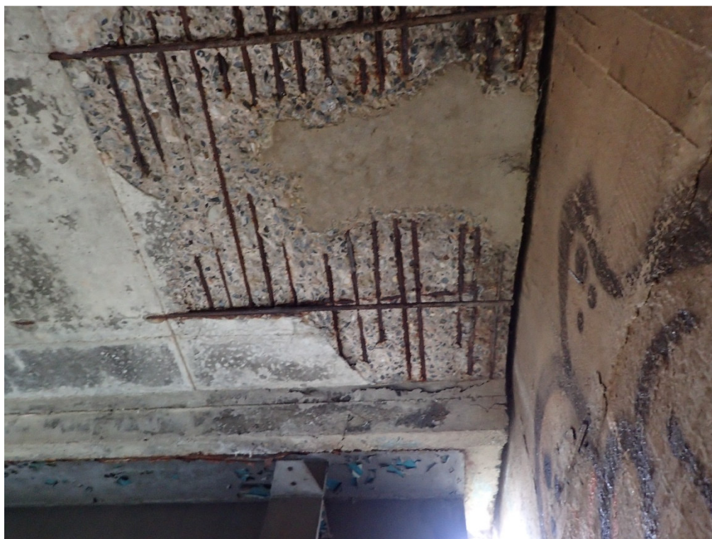
Obr. 13 K02 O01 nejpoškozenější část bet. desky
