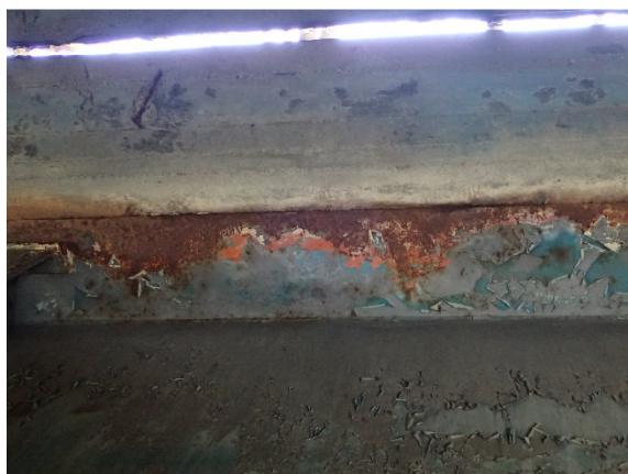
Obr. 22 Příklad koroze horní pásnice hl. nosníku od trhliny v betonu
