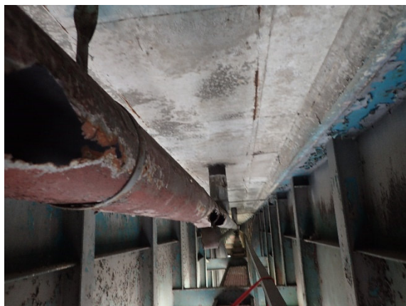
Obr. 15 Zbytky odtokového žlabu
