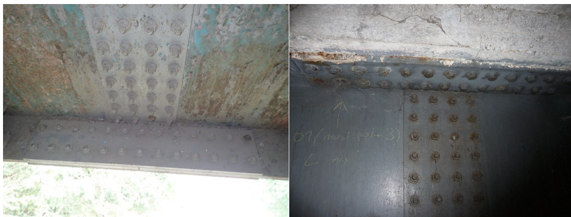
Obr. 5 Chybějící šrouby montážního styku, K02 pravý nosník 4. mont. styk(vlevo), K01 levý nosník 4. mont. styk(vpravo)
