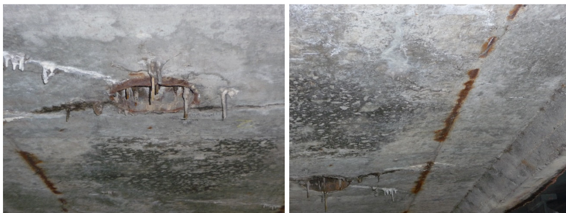
Obr. 12 Nedostatečné krytí – prokreslení výztuže, výluhy pojiva
