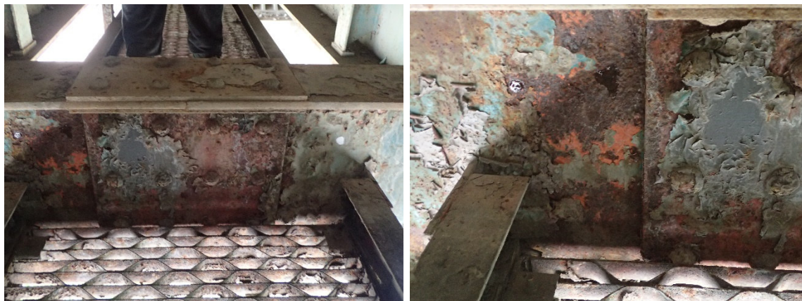
Obr. 23 K02 příčník 1 poškození důlkovou korozí (dole)
